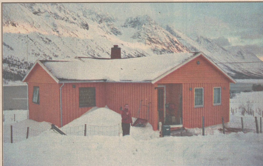
TSI-huset i Nord-Lenangen har vært i drift i et halvt år.
