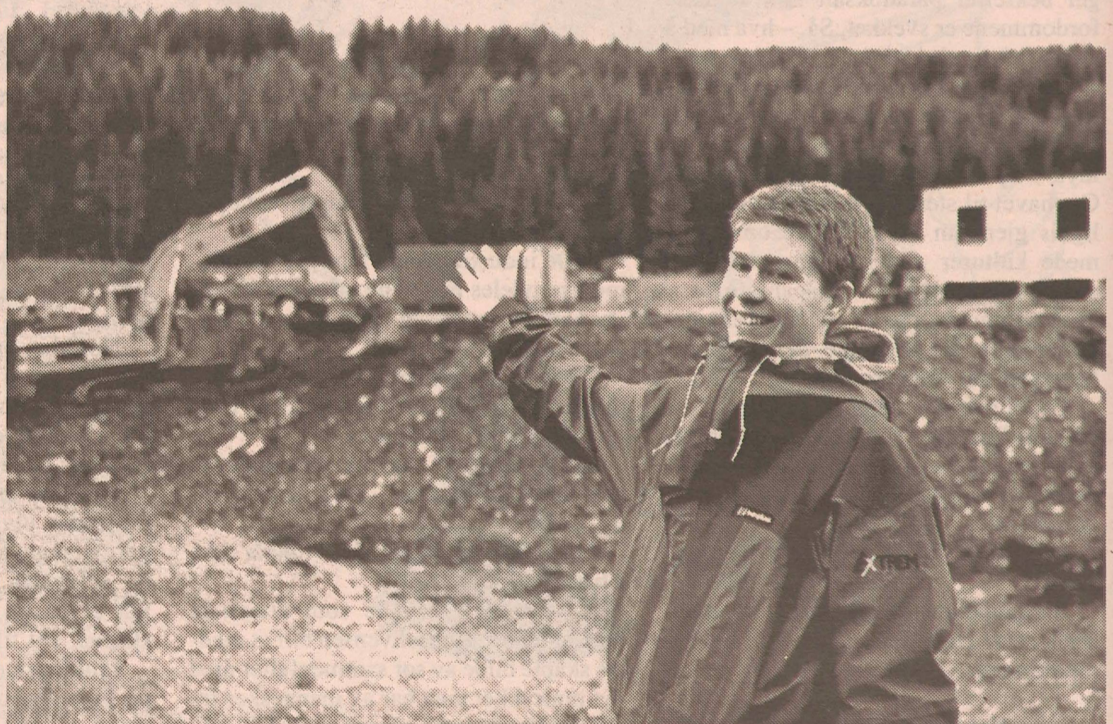
GJØRMEHULL: Her skal den nye idrettshallen ligge. Pål-Morten Grande, leder i brukerutvalget, er glad for at byggingen er kommet igang.
