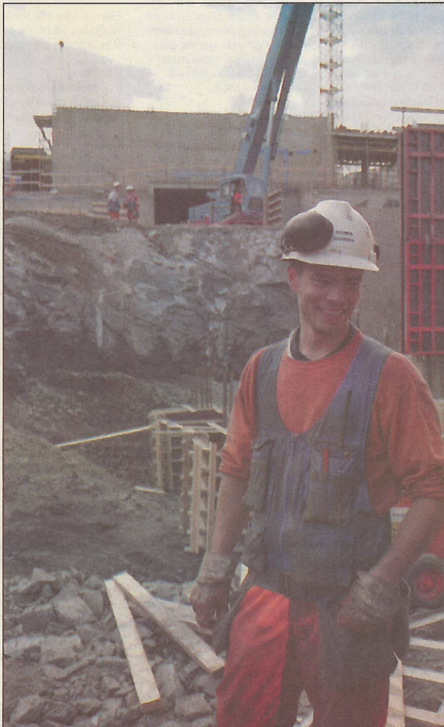
PAUSE: Det er plass til et avbrekk på byggeplassen.
