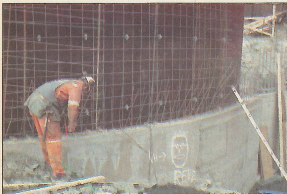
NETTVERK: Forskaling er en viktig del av arbeidet.
