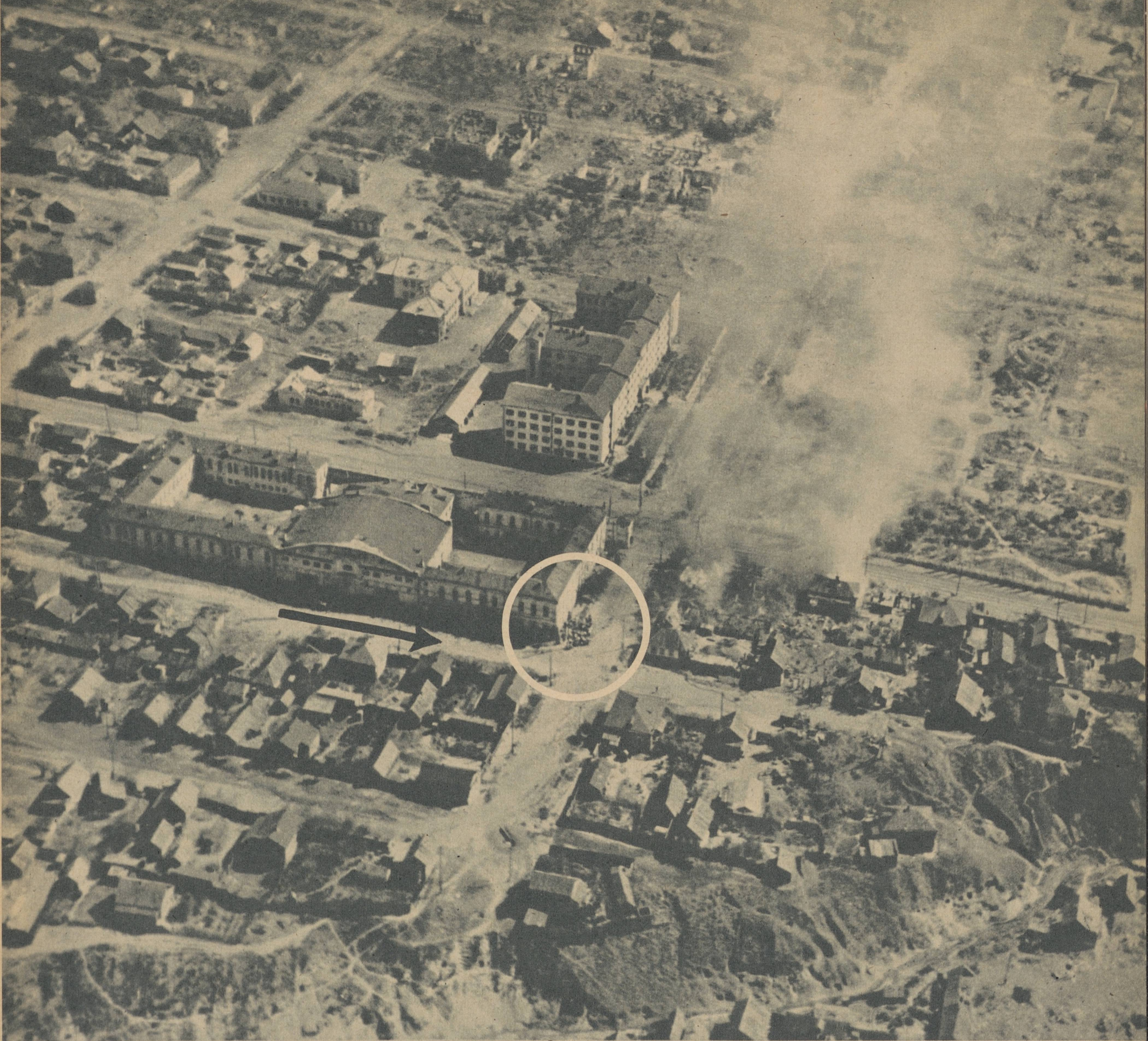
Angrep i lav høyde. Krigskorrespondenten skriver til dette bilde: „Ved høyre sidevegg til den store fabrikkbygningen foran oss har vi oppdaget en flokk mennesker. Flyet vårt setter kurs mot dem, og mens vi flyr mot dem, oppdager vi en større gruppe rødegardister som har søkt dekning bak bygningens hjørne
