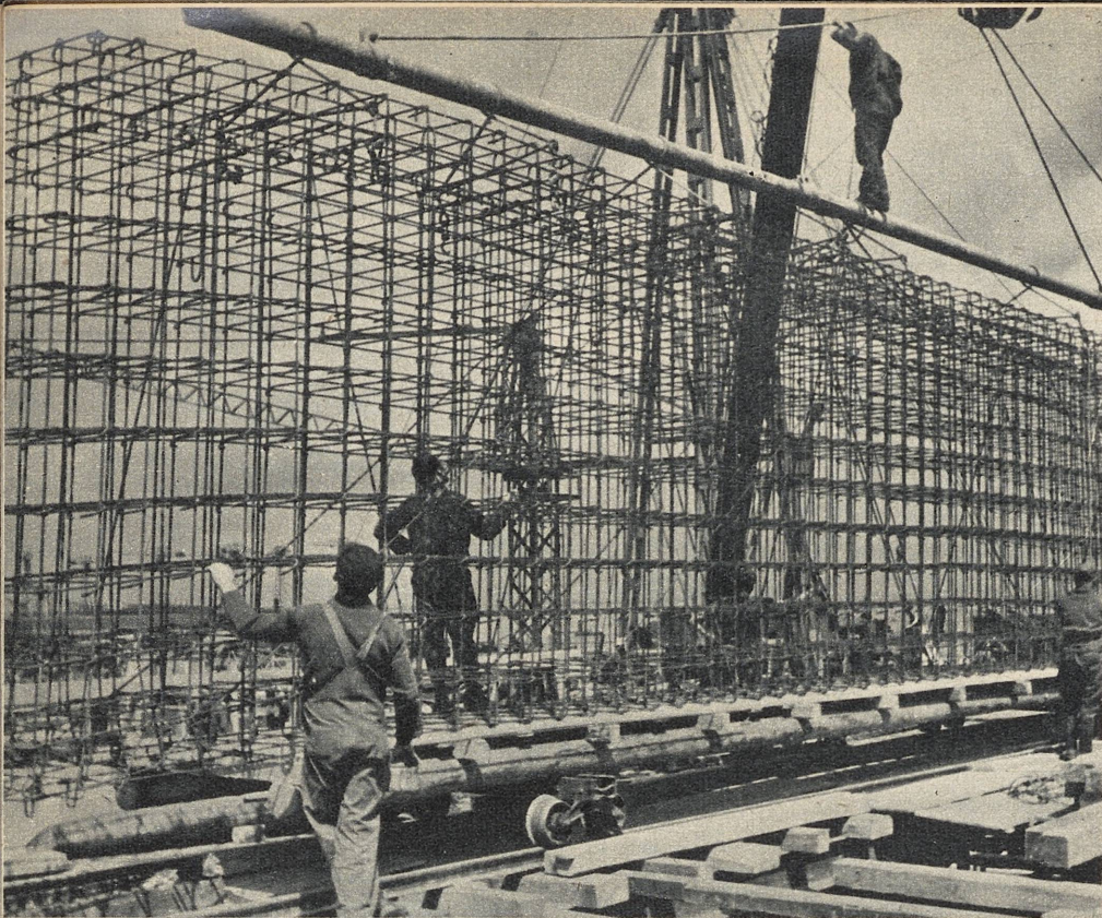
3 I Sørge-Norge. Mektige stålfletverk blir rullet til byggeplassen på lave vogner. De danner skjelettet for de meter-tykke betongvegger i en bunker. Tusener norske arbeidere tjener her til livsopphold for seg selv og sine familier
