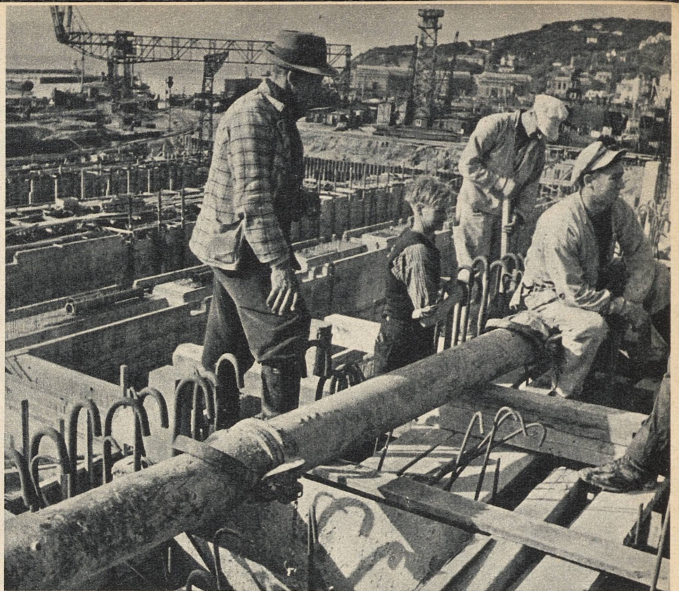
4 Ved fjordene. Betong blir ved hjelp av en spesiell trykkledning pumpet opp på taket av et nesten ferdigbygd marine-beskyttelsesbygg og strømmer uten opphør ned i de meter-tykke hulrom. Dette sparer tid og menneskekrefter
