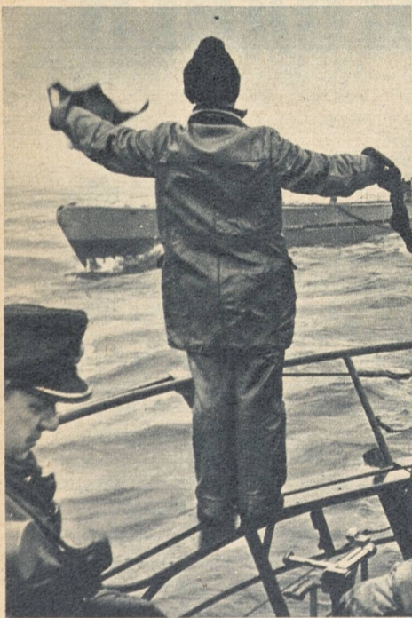
Tanken — sogar während der Fahrt! Ein Flaggensignal zeigt den Beginn der Ölübergabe an. Die Pumpen des Tankers drücken das Öl durch den Schlauch, der in weitem Bogen den fahrenden Schiffen nachschwimmt. Nach beendeter Übernahme holt der Tanker den Schlauch wieder an Bord (Bild rechts). Auch der L. I. (Leitende Ingenieur) hilft
