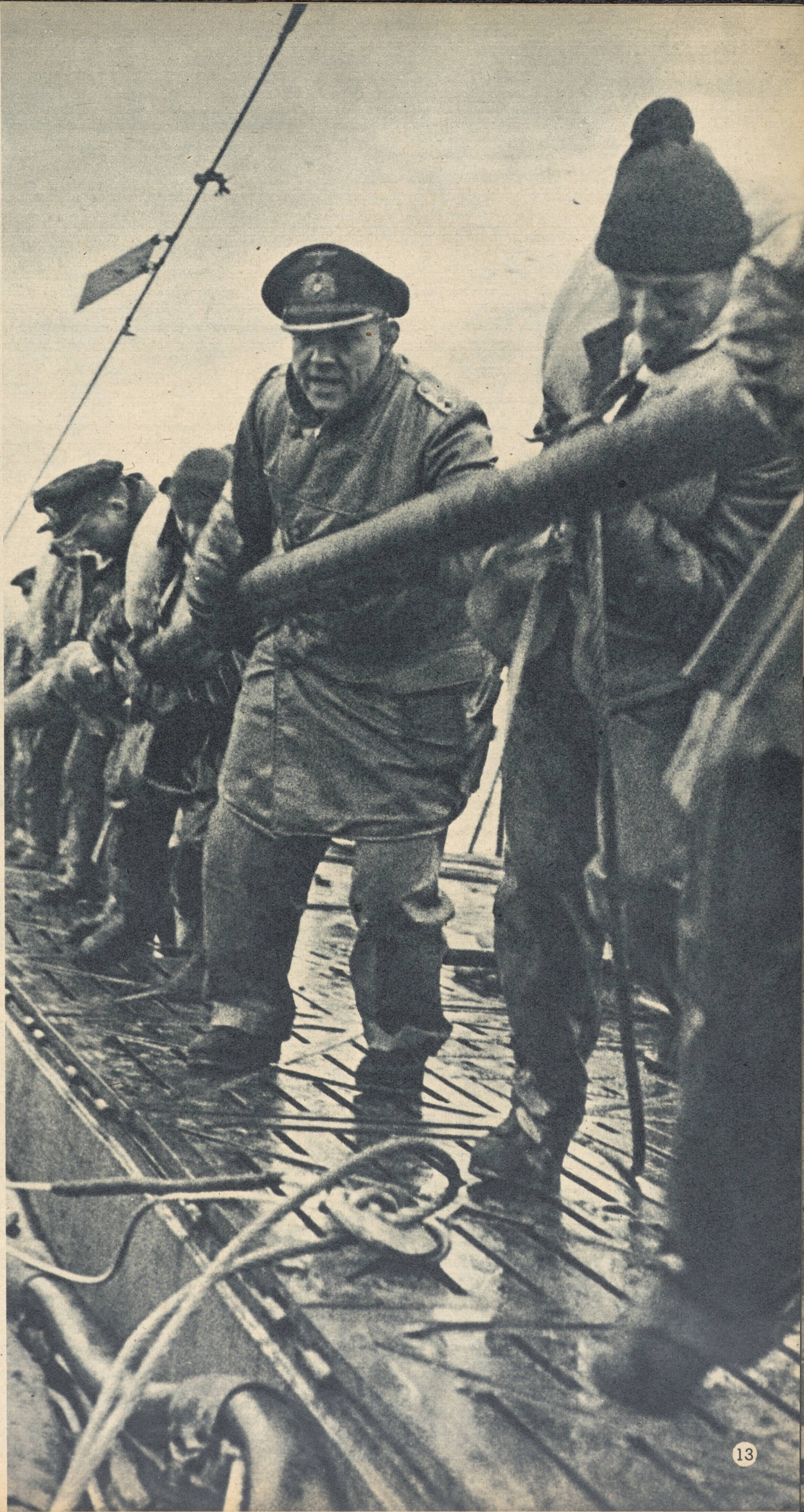
Tanken — sogar während der Fahrt! Ein Flaggensignal zeigt den Beginn der Ölübergabe an. Die Pumpen des Tankers drücken das Öl durch den Schlauch, der in weitem Bogen den fahrenden Schiffen nachschwimmt. Nach beendeter Übernahme holt der Tanker den Schlauch wieder an Bord (Bild rechts). Auch der L. I. (Leitende Ingenieur) hilft
