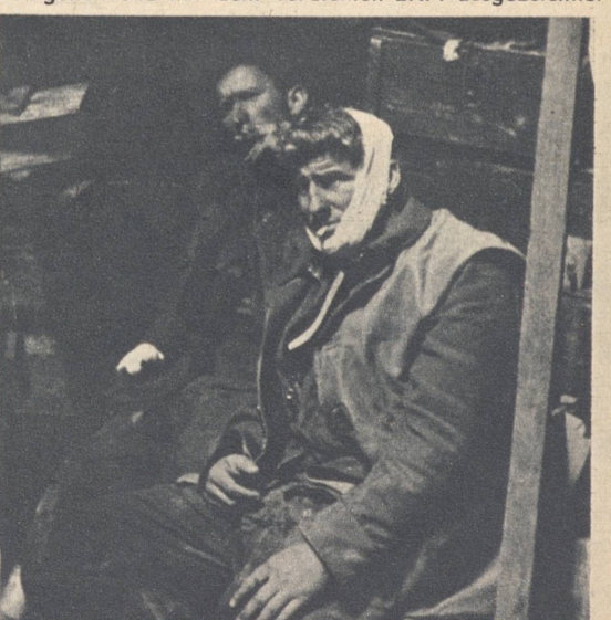
In den wenigen heil gebliebenen Kellern haben die Sanitäter Verbandsplätze eingerichtet. Auch der gefangene Feind wird hier versorgt, wenn er verwundet wurde
