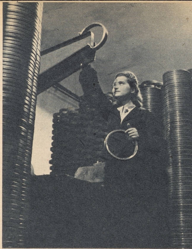
Praktiske metoder. De ofte meget enkle transportanleggene er interessante. Disse valselager-ringene for ubåt-diselmotorene løper gjennom et hull i reggen direkte til neste arbeidsplass
